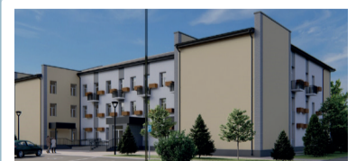
Реконструкція колишнього гуртожитку за адресою: с. Олександрівка, вул. Доновського 77, під житло для ВПО
