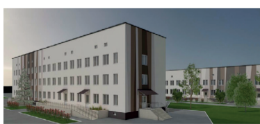
Капітальний ремонт приміщень Слобожанської центральної лікарні в селищі Слобожанське
