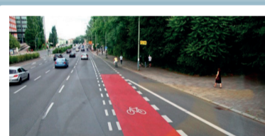
Капітальний ремонт доріг комунальної власності, облаштування велосипедної інфраструктури
